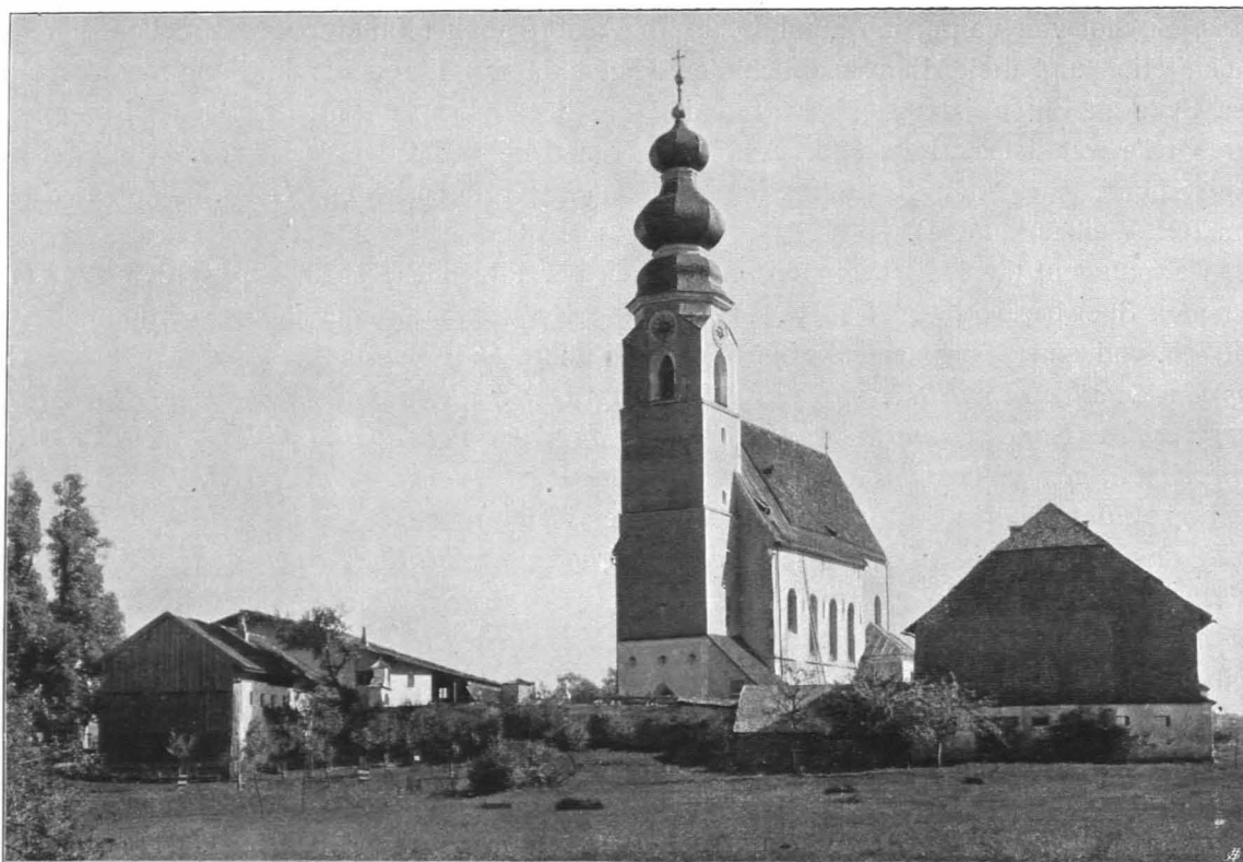
Fig. 49 Irrsdorf, Filialkirche, Ansicht von Südwesten (S. 58)
