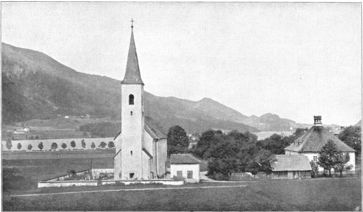
Fig. 8 Fuschl, Pfarrkirche von Osten (S. 9)
