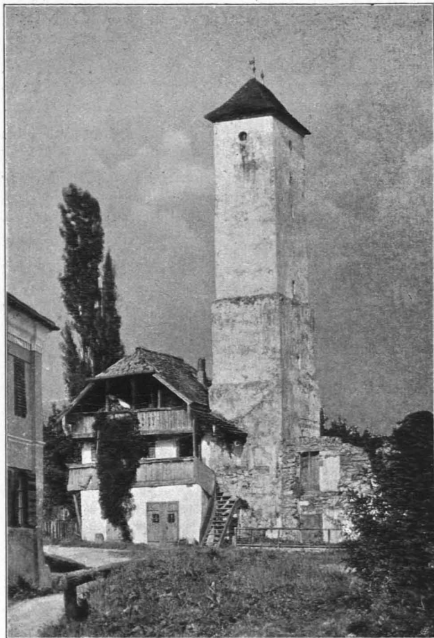
Fig. 578 Oberndorf, Wasserturm (S. 573)
