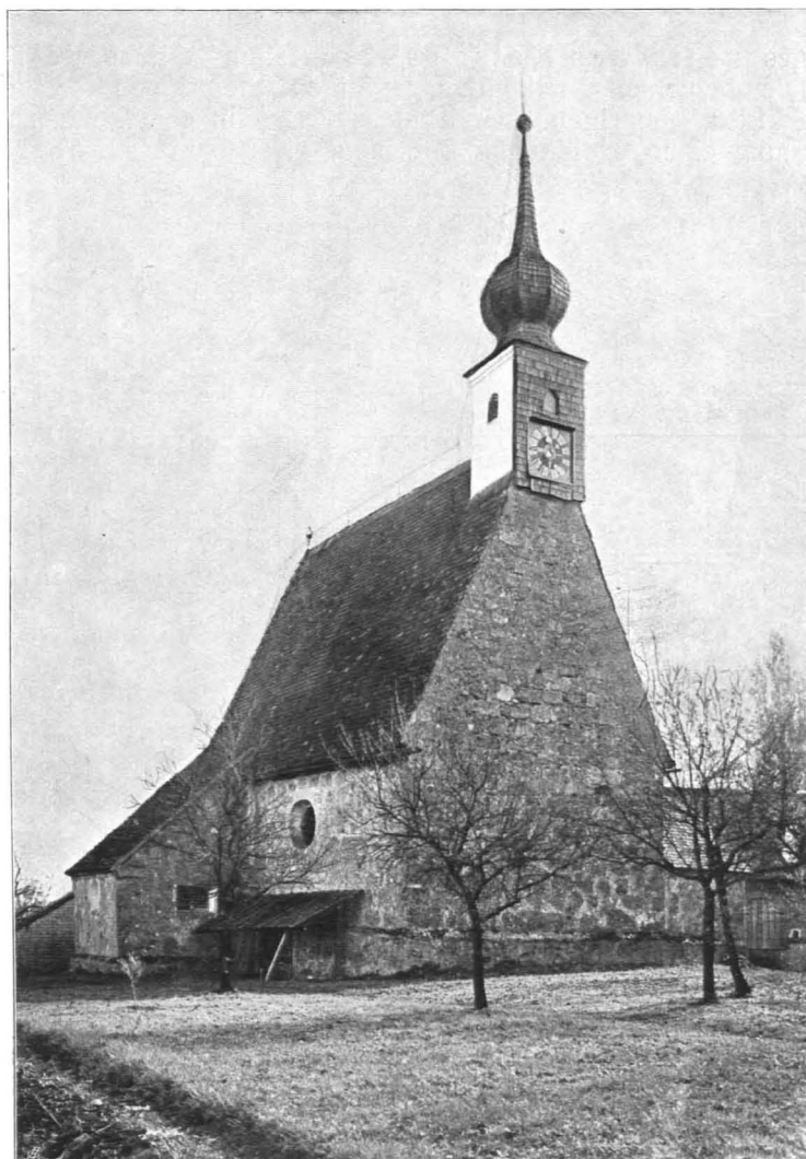
Fig. 446 Holzhausen, Filialkirche, Ansicht von Nordwesten (S. 457)
