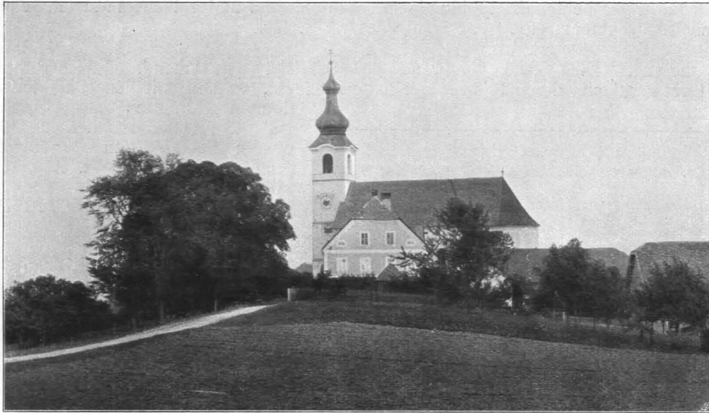
Fig. 431 St. Georgen, Pfarrkirche und Pfarrhof, Ansicht von Süden (S. 444)
