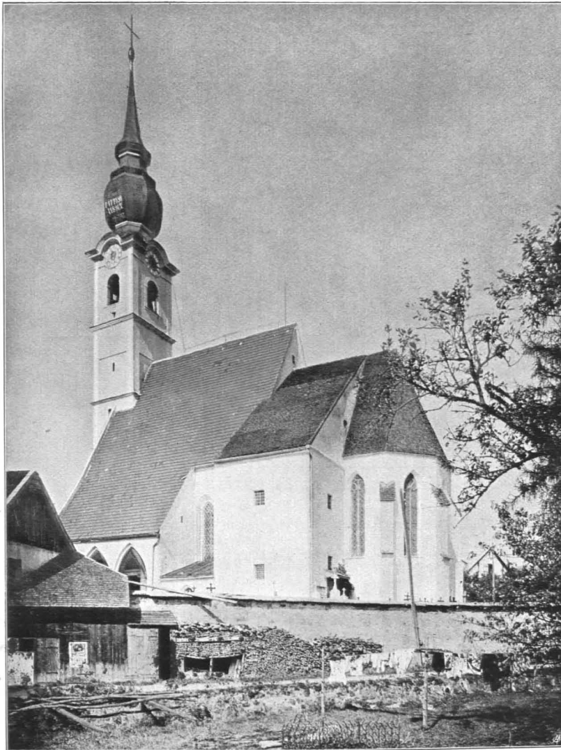
Fig. 359 Anthering, Pfarrkirche, Ansicht von Südosten (S. 371)
