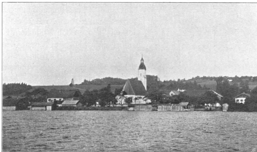
Fig. 341 Seeham, Gesamtansicht von Nordosten (S. 350)
