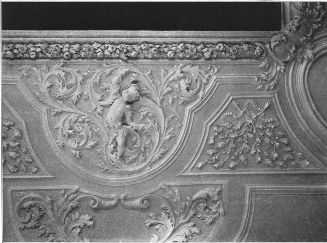
Fig. 301 Mattsee, Propstei, Stuckplafond, um 1700 (S. 307)
