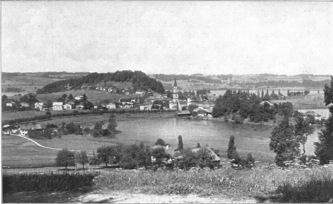
Fig. 265 Mattsee, Gesamtansicht von Südosten
