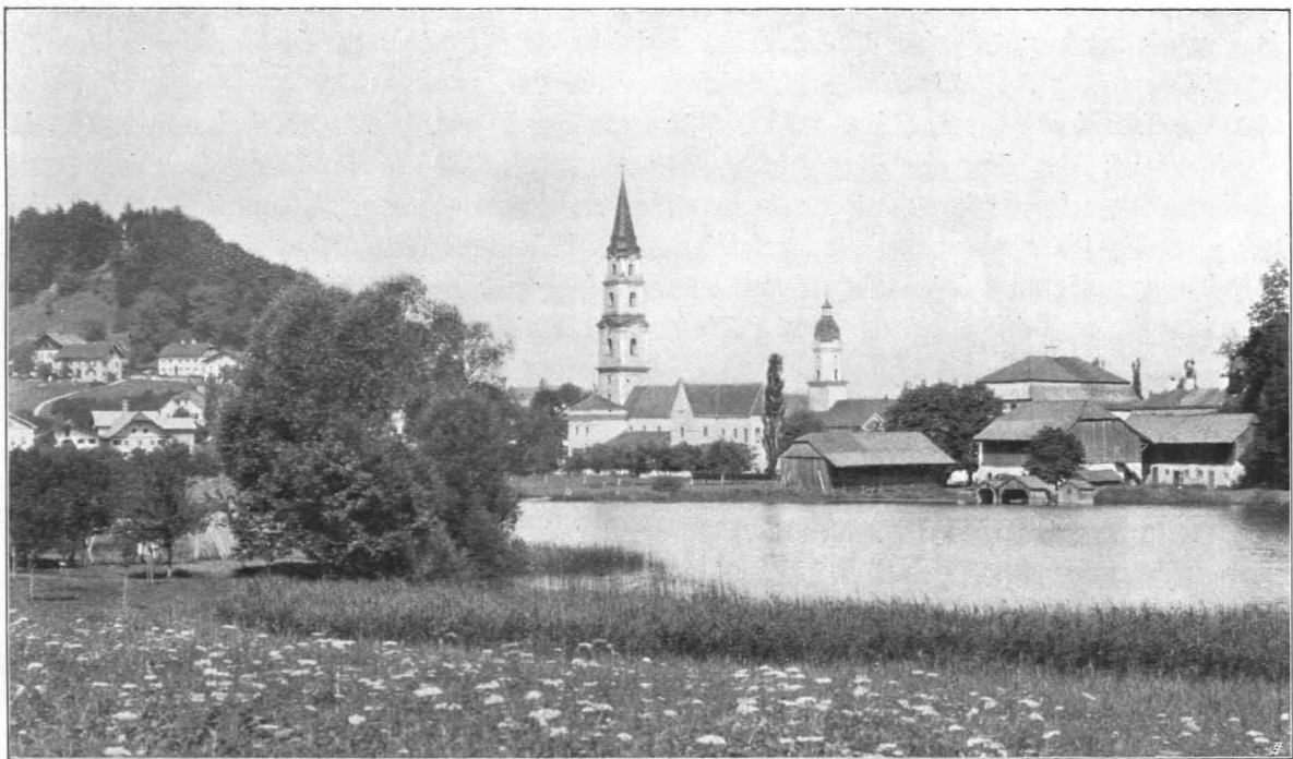
Fig. 269 Mattsee, Ansicht der Stifts- und der Pfarrkirche von Südosten (S. 274)
