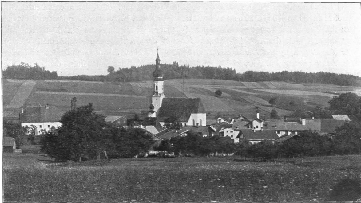
Fig. 255 Berndorf, Gesamtansicht von Südosten (S. 254)
