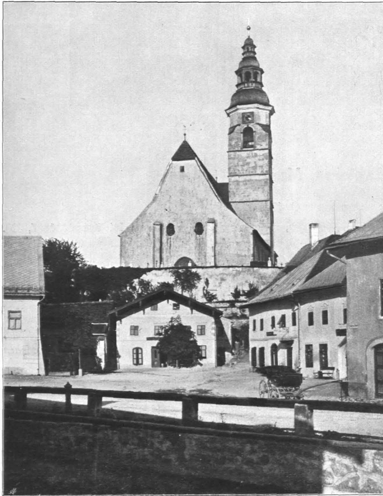
Fig. 164 · Straßwalchen, Pfarrkirche, Westansicht (S. 170)
