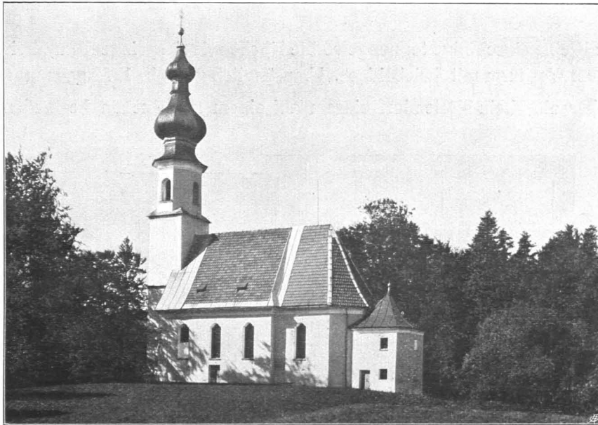
Fig. 68 St. Johann am Berge, Filialkirche, Ansicht von Südosten (S. 72)
