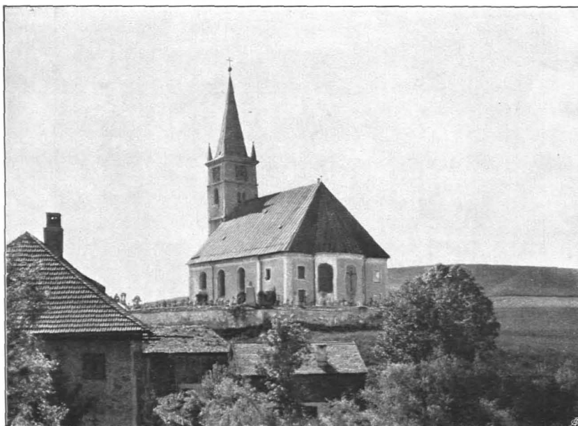
Fig. 38 Henndorf, Pfarrkirche von Südosten (S. 46)
