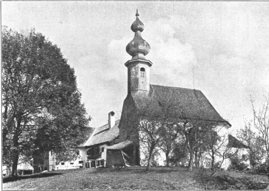
Fig. 35 Dötleinsdorf, Filialkirche, von Südwesten (S. 41)
