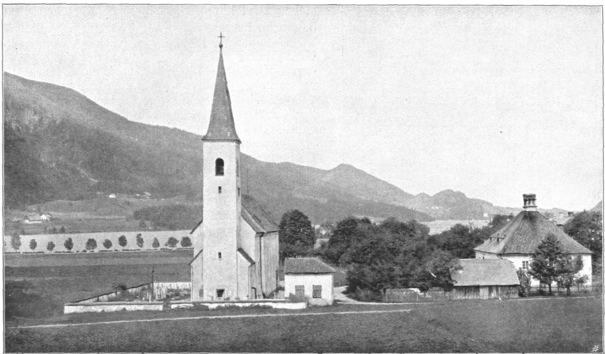
Fig. 8 Fuschl, Pfarrkirche von Osten (S. 9)
