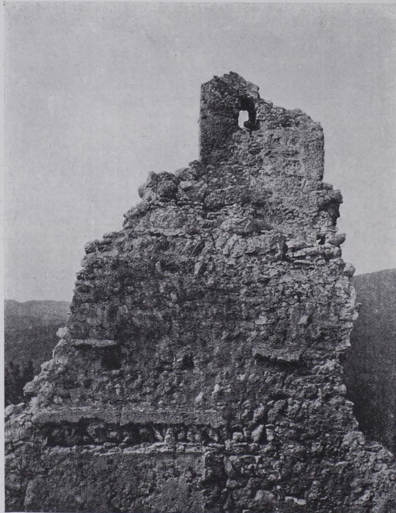
Fig. 212. Baden, Ruine Ratheneck, Umfassungsmauer mit Fischgrätenmauerwerk (S. 151).
