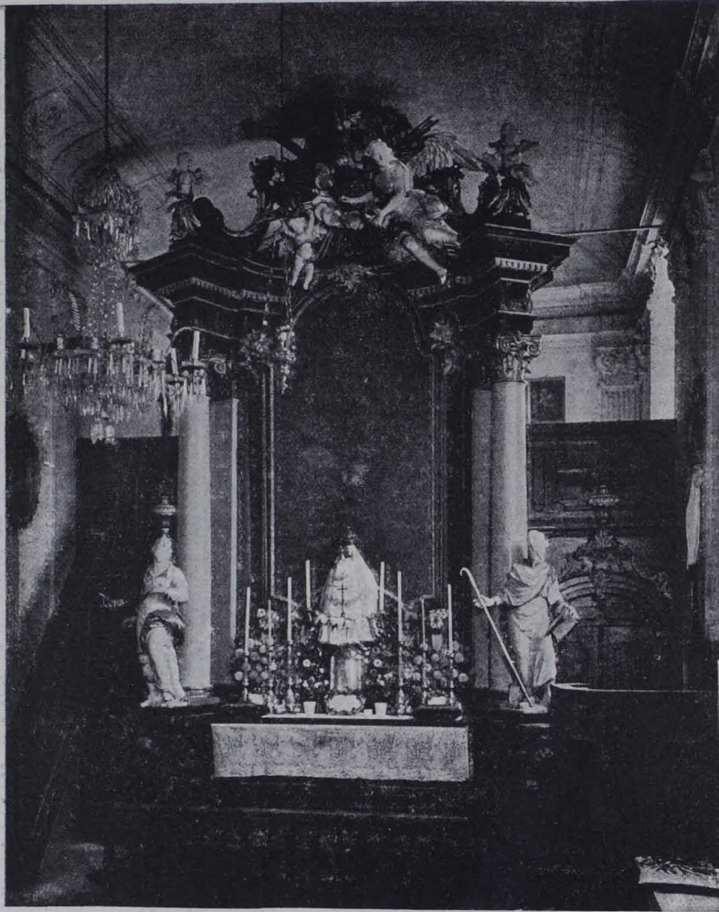
Fig. 152. Baden, Schloßkapelle Gutenbrunn (demoliert) (S. 98).
