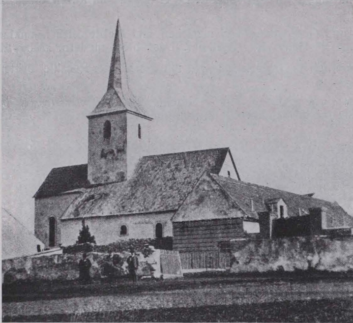
Fig. 368. Grillenberg, Alte Pfarrkirche (1910 demoliert) (S. 282).
