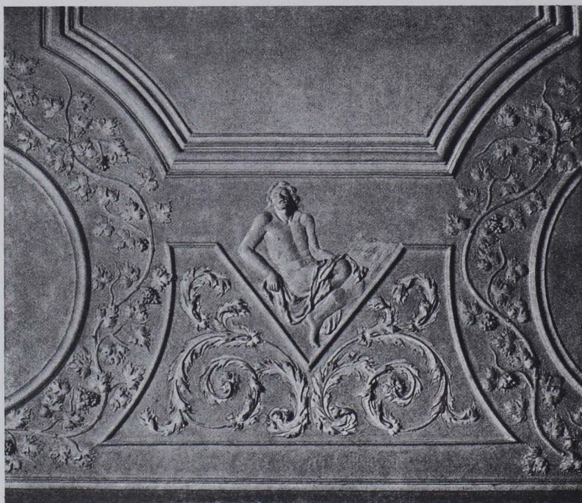
Fig. 281. Schloß Kottingbrunn, Stuckplafond im zweiten Stock (S. 208).
