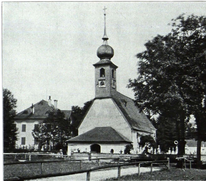
Fig. 416 Niederalm. Filialkirche und Schloß Lasseregg, Ansicht von Südwesten (S. 433)
