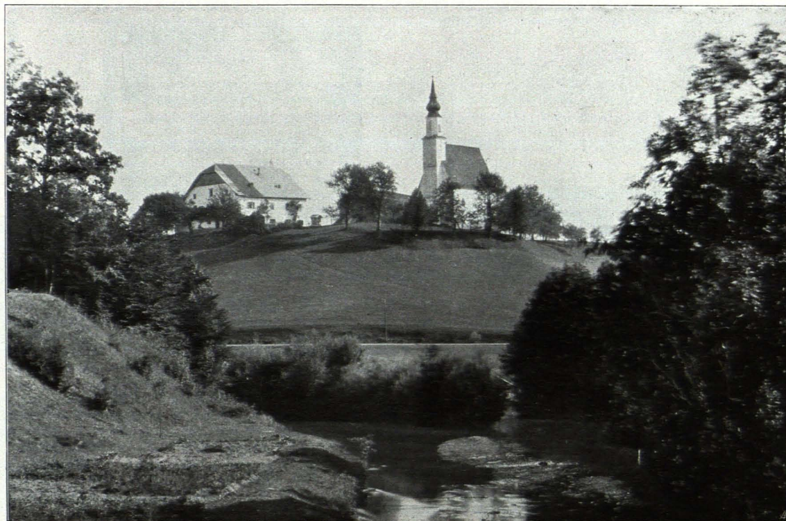
Fig. 405 Mühlberg. Filialkirche, Ansicht von Südwesten (S. 426)
