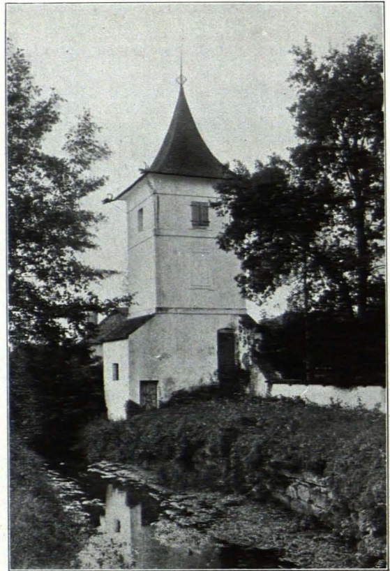
Fig. 396 Fronburg. Wasserturm (S. 414)
