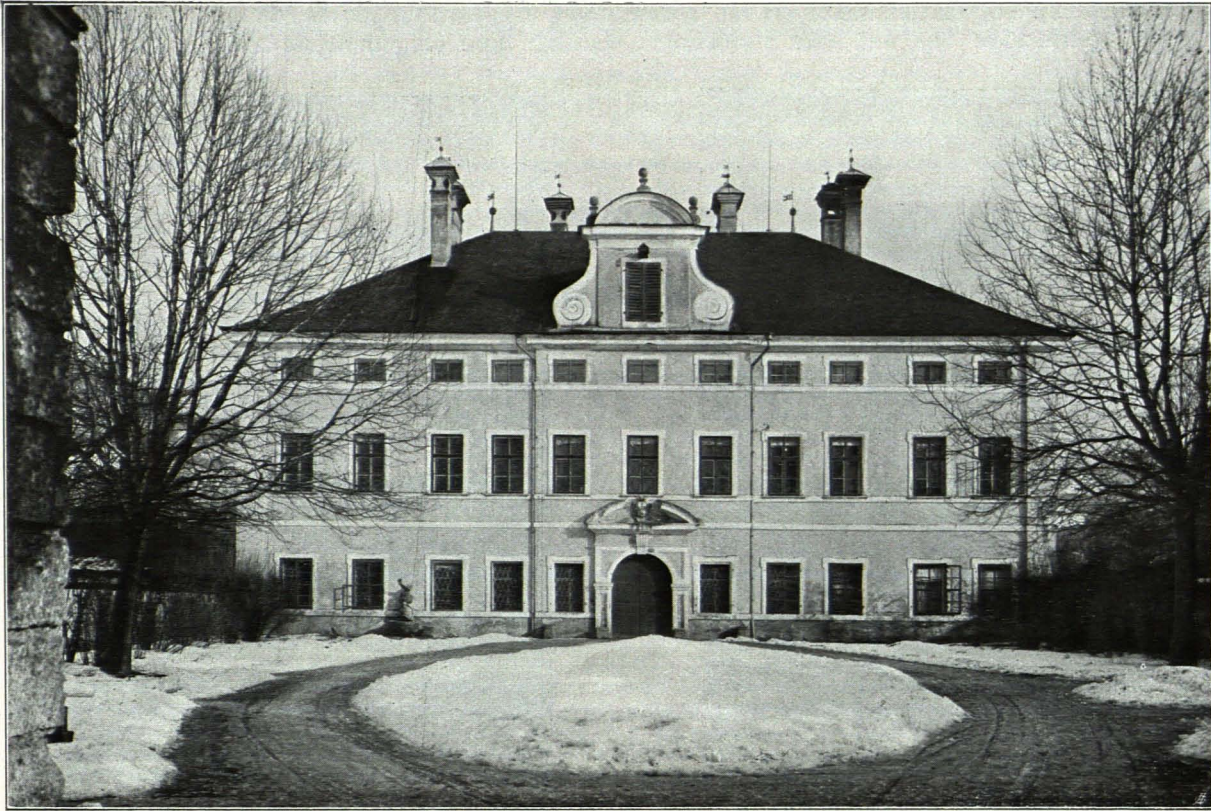
Fig. 392 Fronburg. Ansicht von Westen (S. 413)
