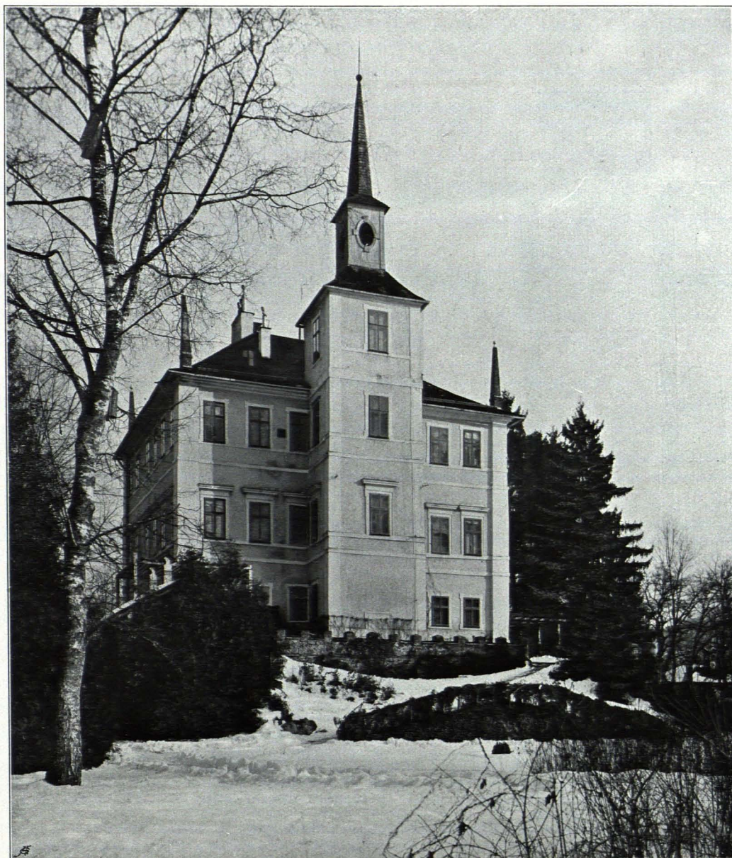
Fig. 385 Emsburg. Ansicht von Nordwesten (S. 408)
