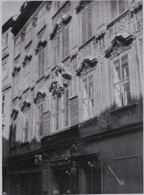
Fig. 45 I., Sonnenfelsgasse Nr. 7. Beispiel eines barocken Stadthauses mit reicher Stuckfassade (IV)
