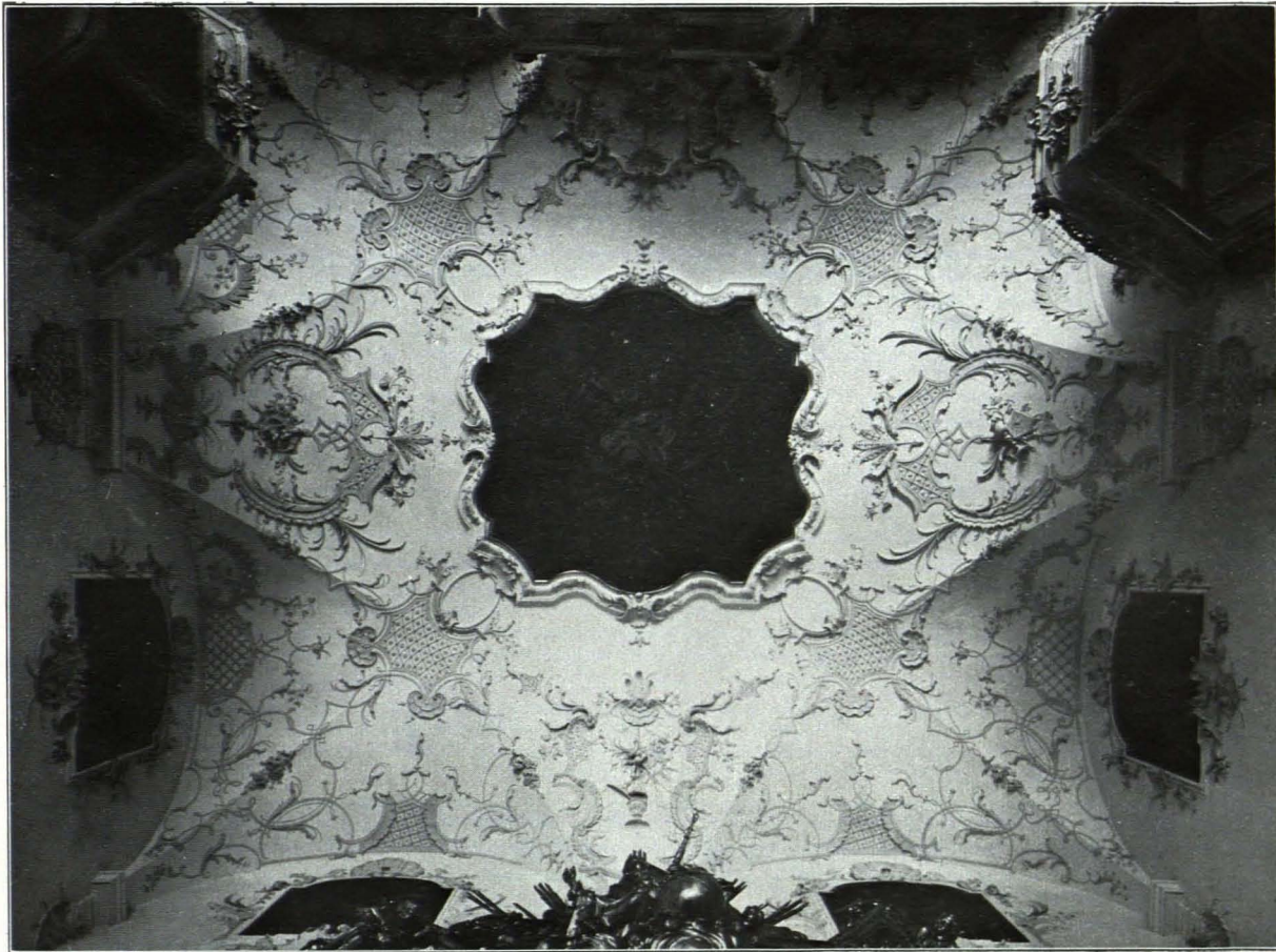
Fig. 278 Leopoldskron. Gewölbe der Kapelle (S. 309)
