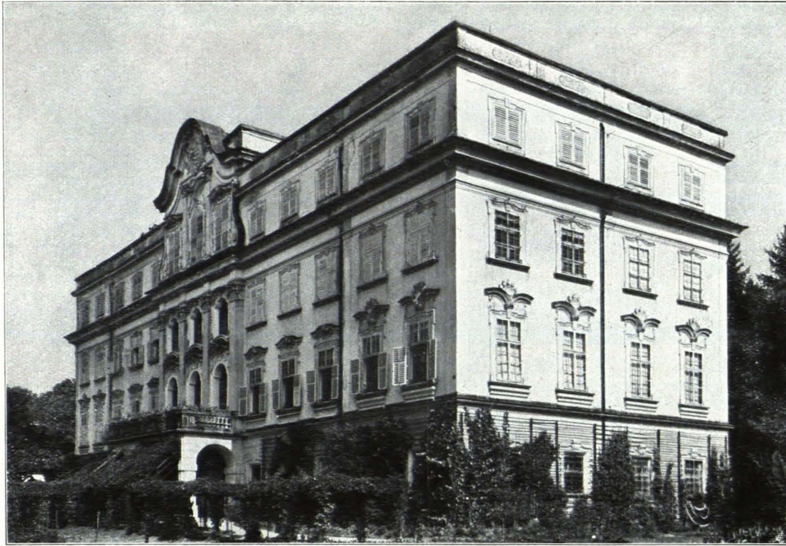
Fig. 272 Leopoldskron. Ansicht von Südosten (S. 305)
