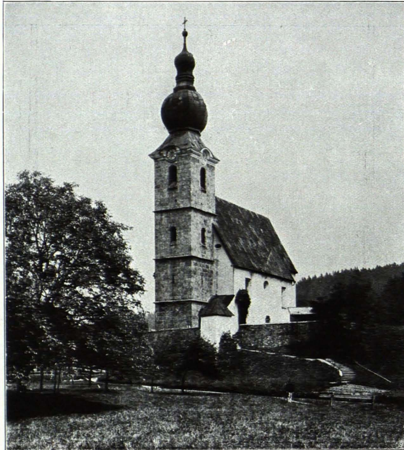
Fig. 260 St. Leonhard. Filialkirche, Ansicht von Südwesten (S. 281)
