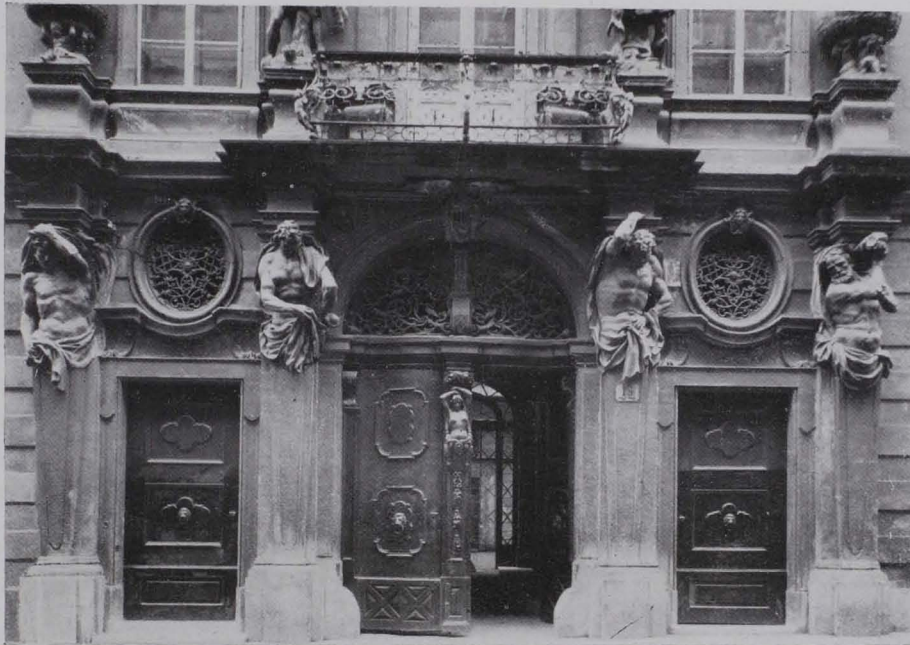
Fig. 12 I., Singerstraße Nr. 16. Barockportal des Palais Breuner (IV). Beispiel eines Stadtpalastes aus der Blütezeit der Wiener Barocke
