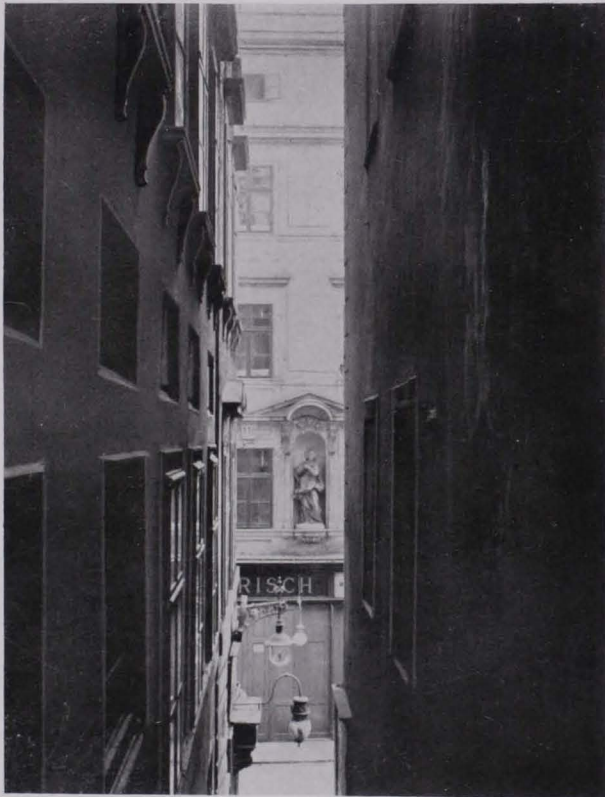
Fig. 35 Blick von der Höhe der Stiegenenge (abgebrochen) der Wächtergasse im I. Bezirk gegen den Tiefen Graben (ehemaliges Bett des Ottakringerbaches)
