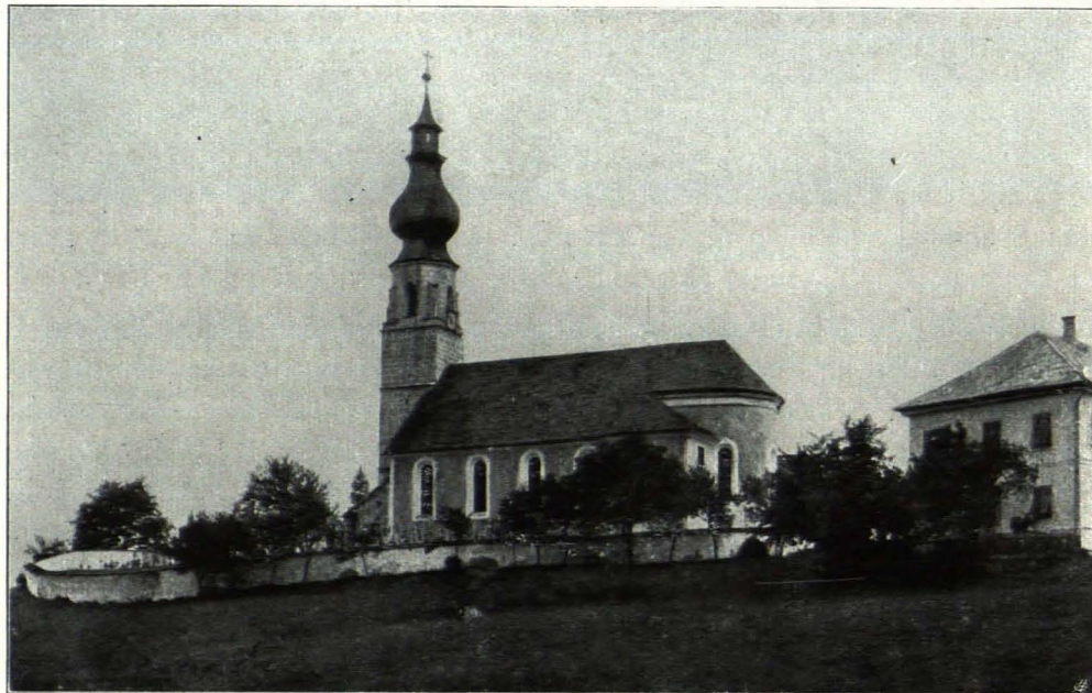
Fig. 148 Hallwang, Piarrkirche, Äußeres von Südosten (S. 158)
