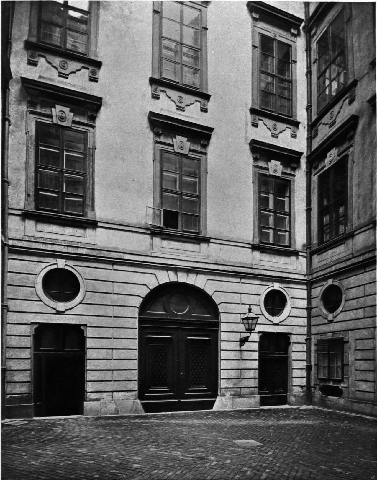
Abb. 214 Der mittlere Hof im Reichskanzleigebäude (erbaut von Joh. Luk. v. Hildebrandt)
