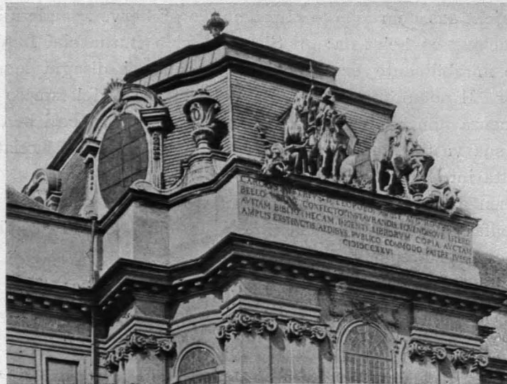
Abb. 184 Teil der Fassade der Hofbibliothek gegen den Josefsplatz, nach Cam. List, vgl. Abb. 179
