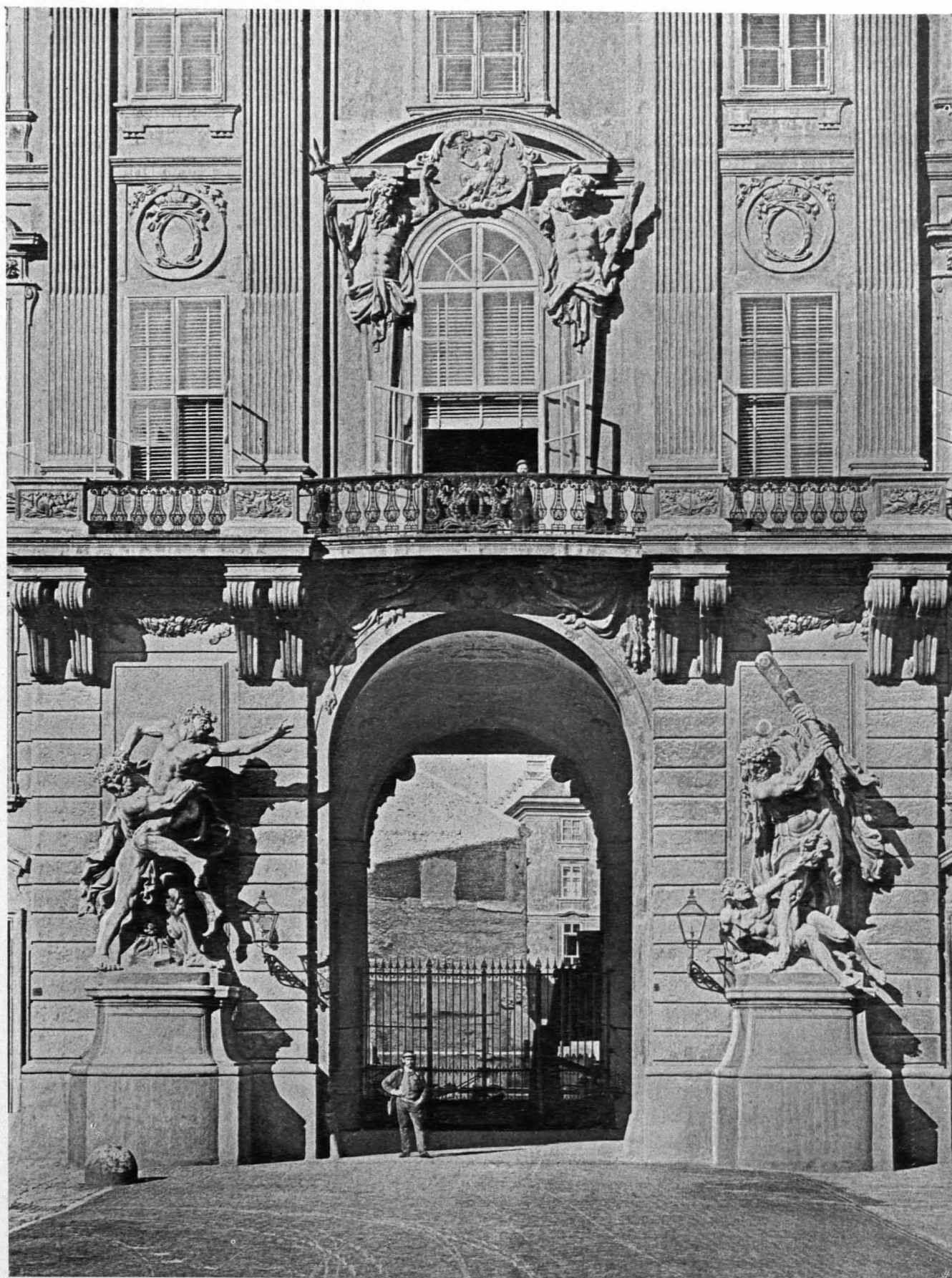
Abb. 230 Teil der Reichskanzleifassade mit dem Tore gegen Skt. Michael, im Zustande vor dem Umbaue der neunziger Jahre des 19. Jhs., nach R. Dohme „Barock- und Rokoko-Architektur“.
