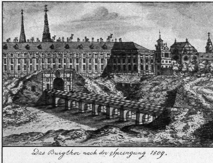
Abb. 123 „Das Burgthor nach der Sprengung 1809“, lavierte Federzeichnung, k. k. Hofbibliothek
