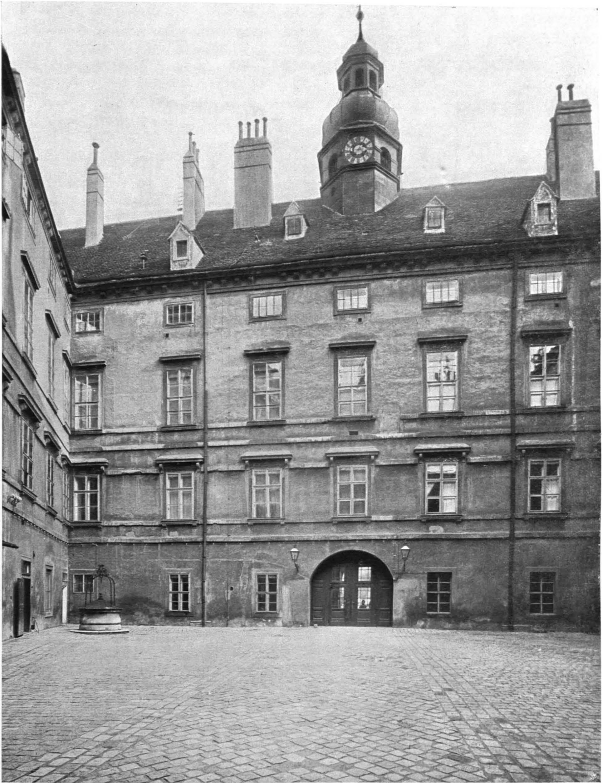
Abb. 80 Hof der „Amalienburg“, Blick gegen die Eingangsseite
