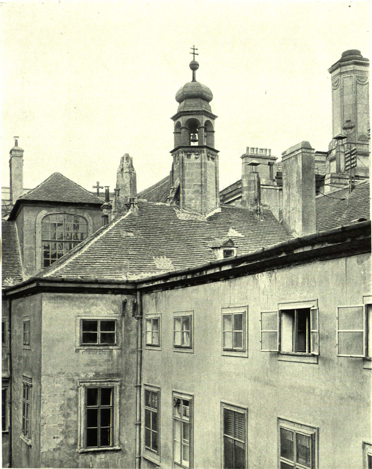
Abb. 3 Die innere Südecke des Schweizerhofes der k. k. Hofburg
