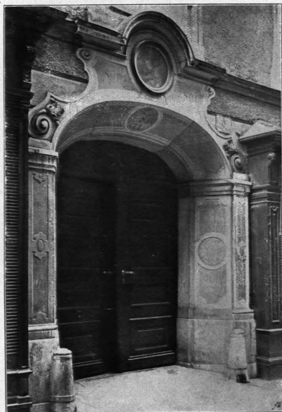
Fig. 404 Portal des Hauses Siegmund-Haffner- Gasse Nr. 6 (S. 297)
