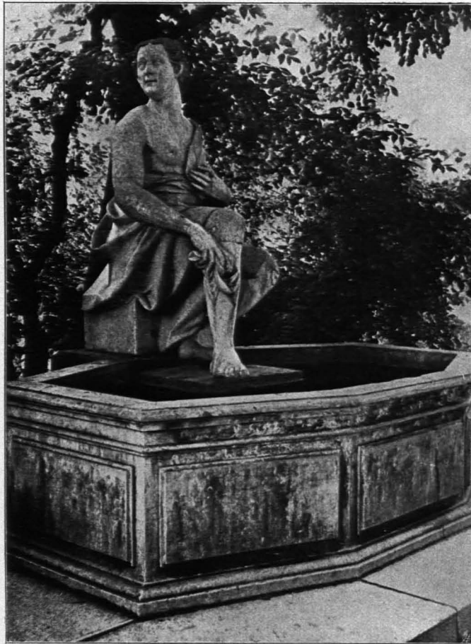
Fig. 276 Mirabellpark, Brunnen (S. 211)
