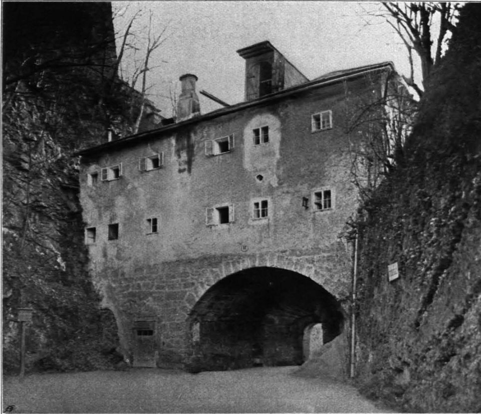
Fig. 209 Hohensalzburg, vierter Sperrbogen (S. 134)
