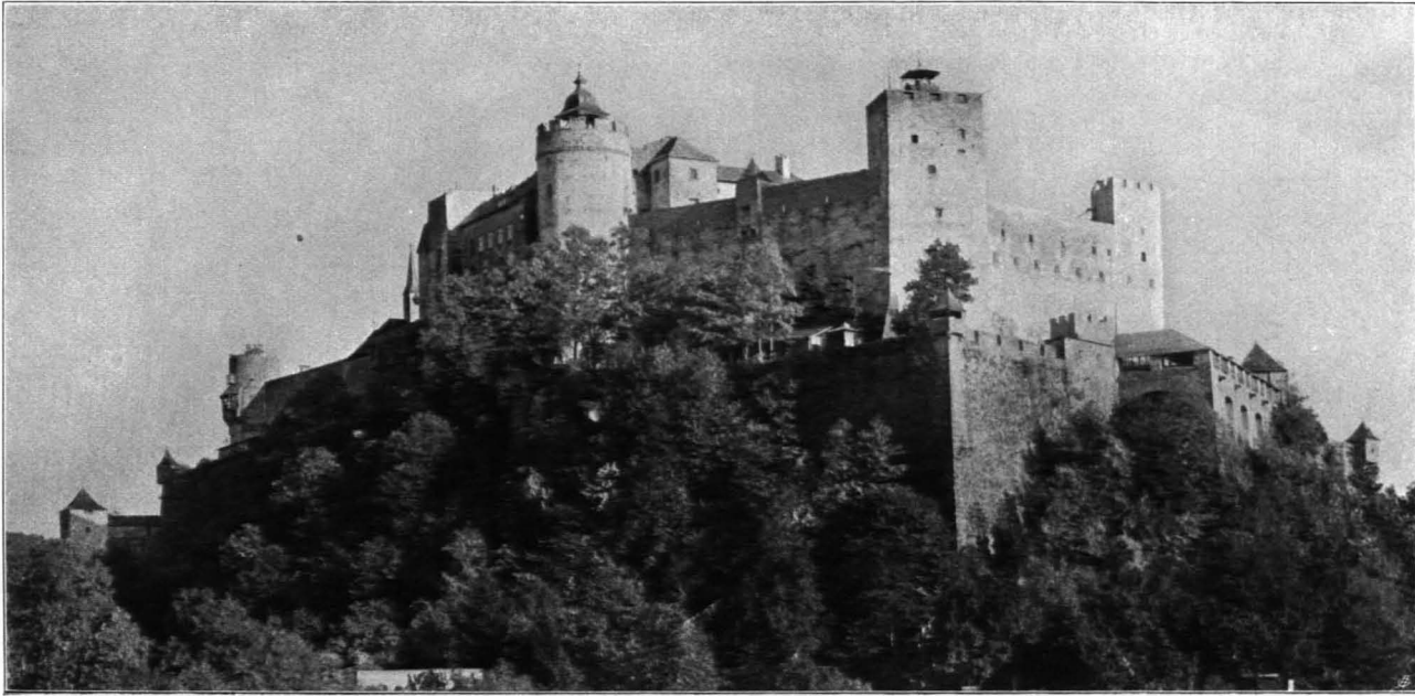
Fig. 204 Hohensalzburg, Blick von Nordwesten (S. 131)
