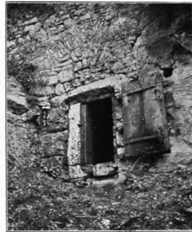
Fig. 206 Hohensalzburg, Außentür des unter- irdischen Ganges gegen Nonntal (S. 134)
