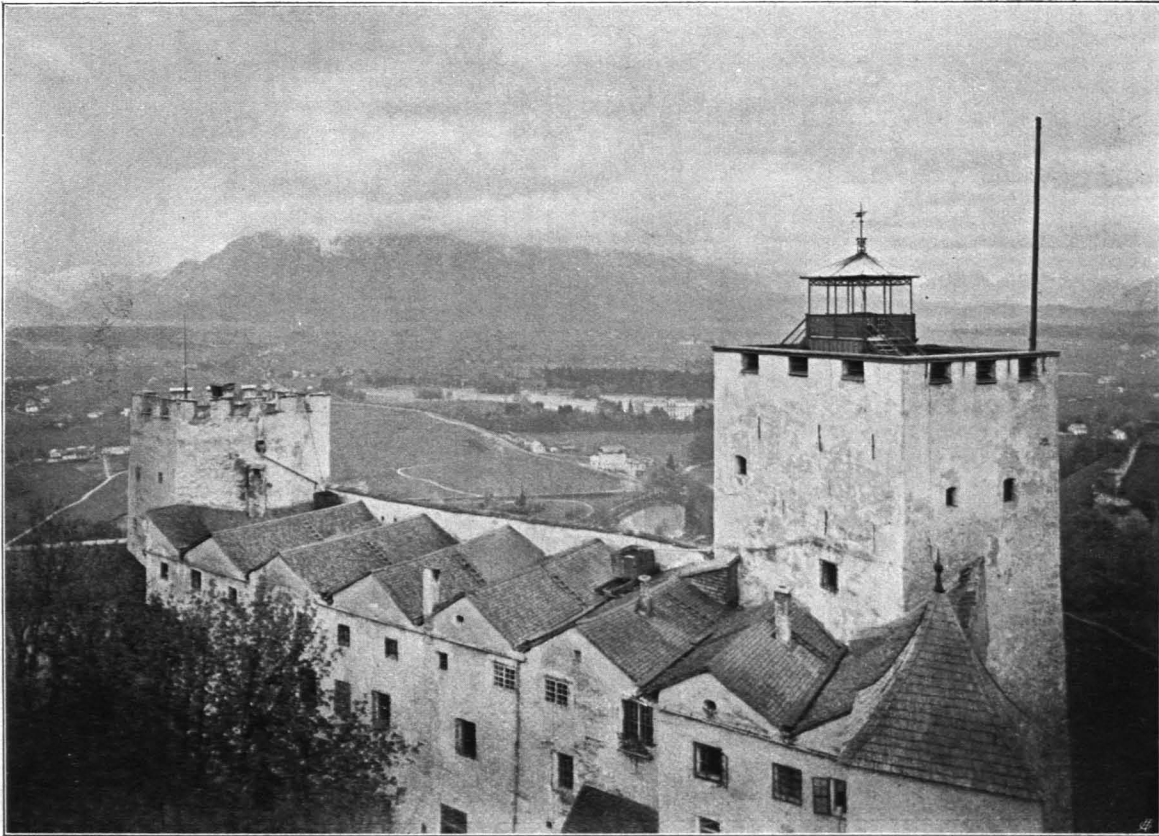
Fig. 120 Hohensalzburg, Hasenturm (hinten), Stallgebäude, Reckturm (vorn) (S. 90)
