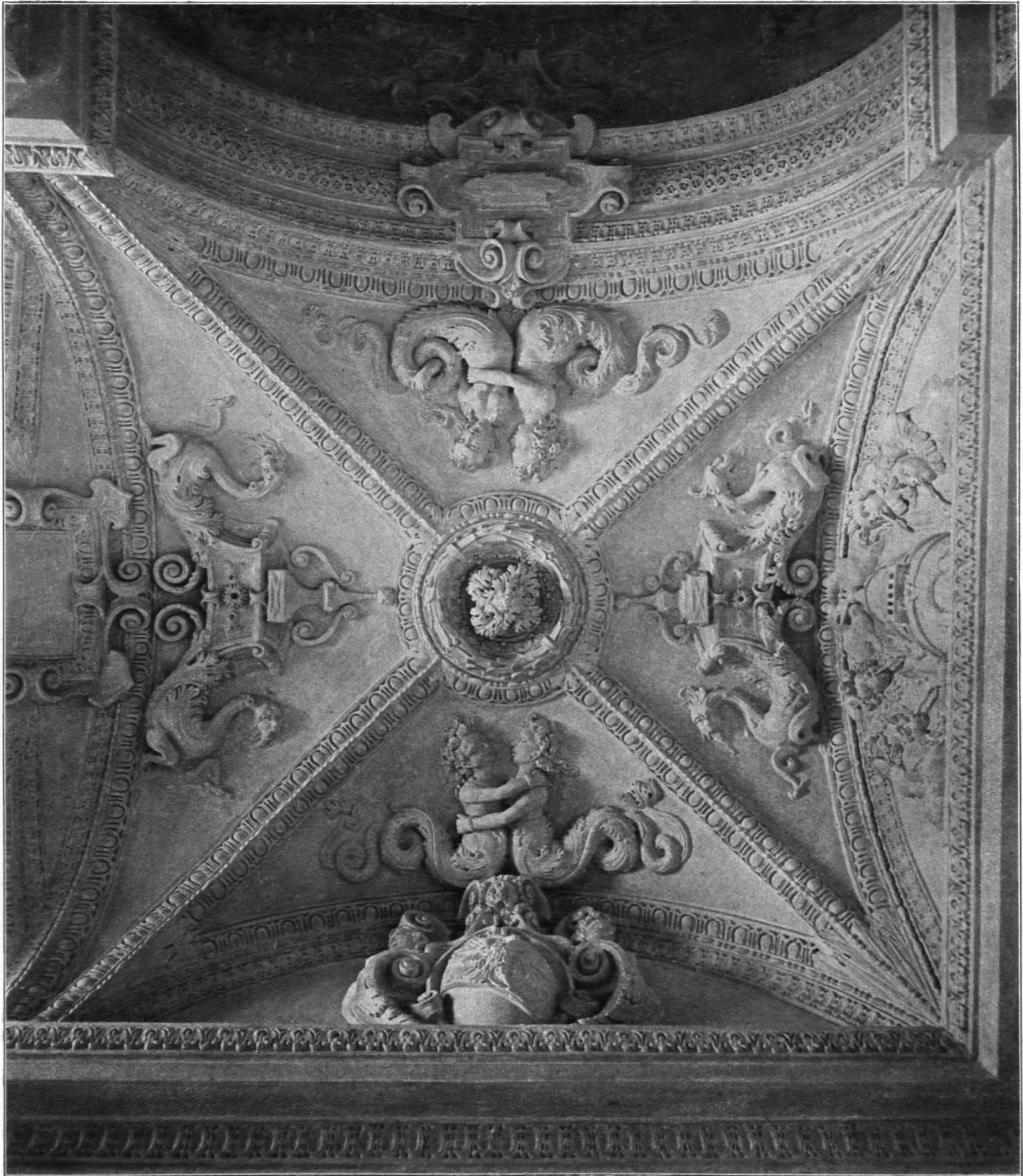
Fig. 75 Neubau, Stuckdecke im Stiegenhaus (S. 60)
