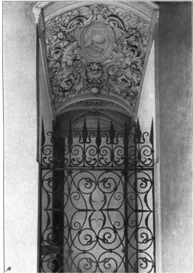
Fig. 47 Gitter und Decke der Stiege im Südtrakt (S. 39)
