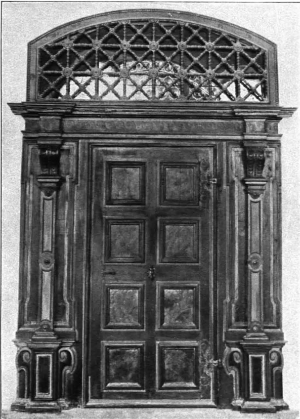
Fig. 46 Residenz, Tür im Totenoratorium (S. 38)
