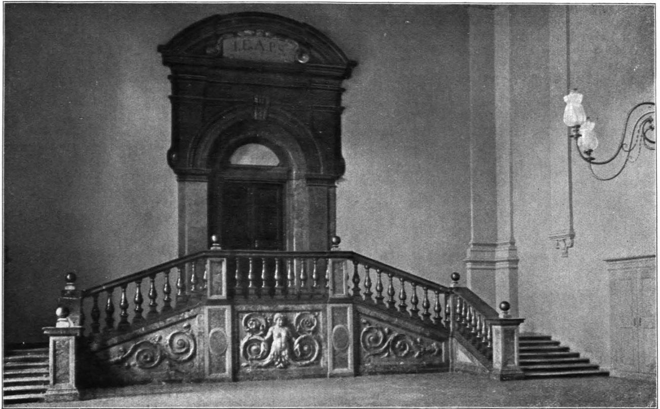
Fig. 14 Residenz, westliche Schmalseite des Karabinersaales (S. 17)
