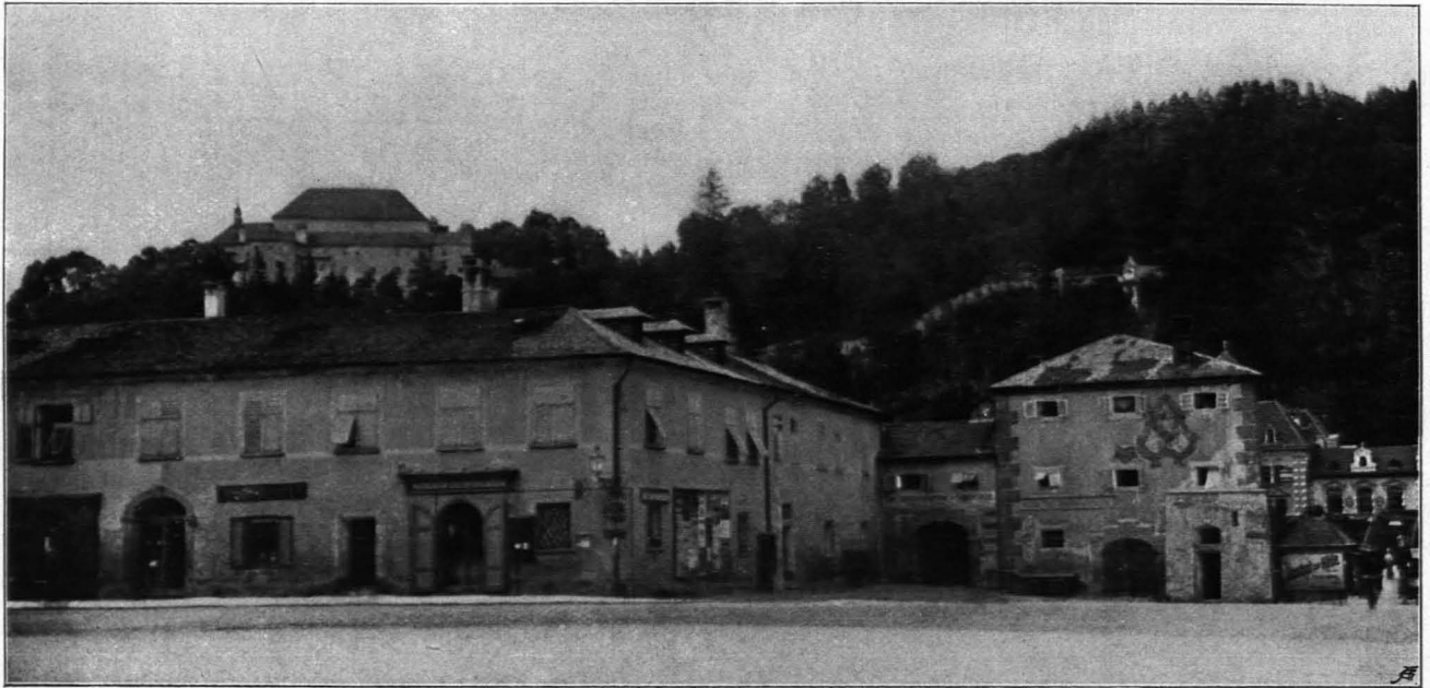
Fig. 283 Städtische Gebäude am Mozartplatz (S. 216)
