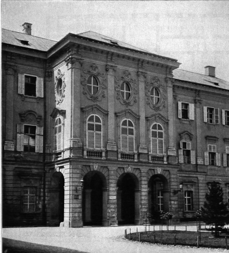
Fig. 245 Mirabell, Westtrakt, Hoffassade (S. 194)
