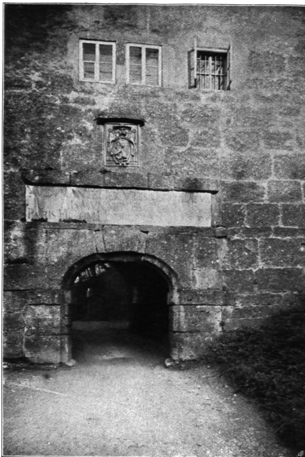
Fig. 210 Hohensalzburg, vierter Sperrbogen, Außenseite (S. 134)
