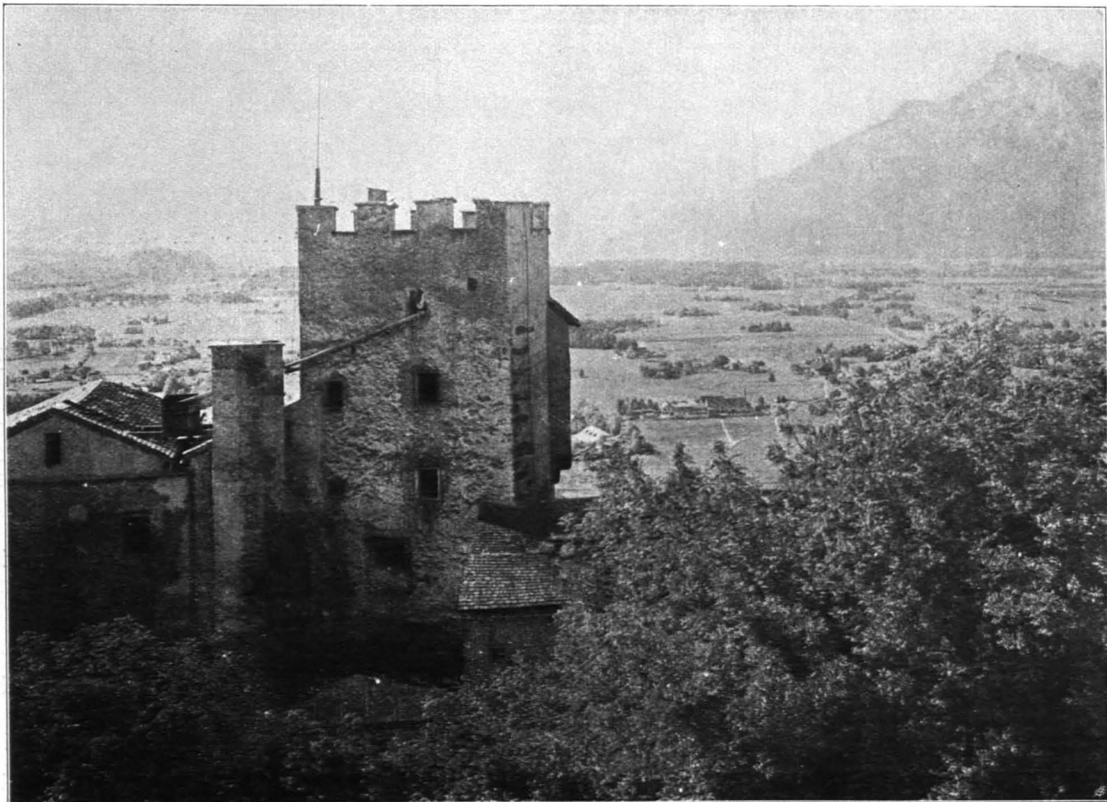
Fig. 117 Hohensalzburg, Geierturm, Blick von der Schloßbastei (S. 90)
