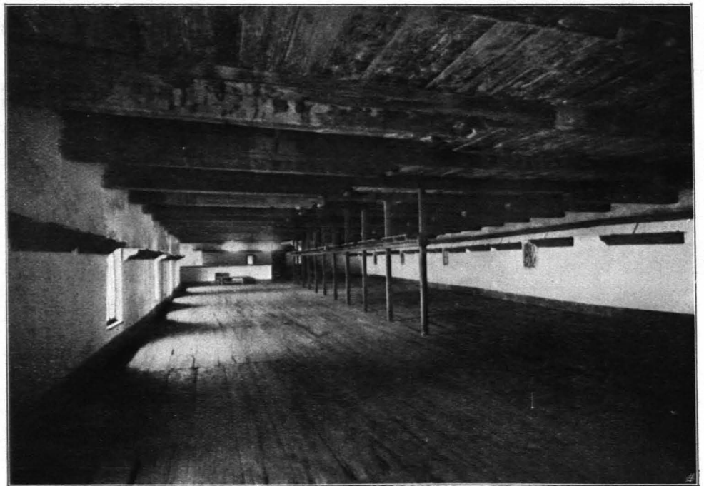
Fig. 131 Hohensalzburg, Saal im Arbeitshaus (S. 95)
