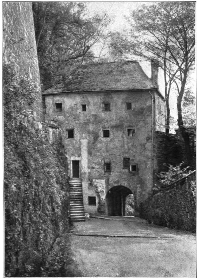
Fig. 91 Hohensalzburg, zweiter Sperrbogen, Ostseite (S. 82)
