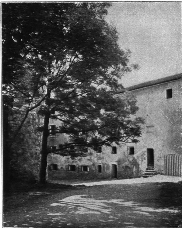
Fig. 121 Hohensalzburg, Stallgebäude (S. 90)
