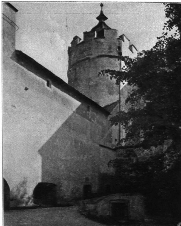
Fig. 122 Hohensalzburg, Mauer mit Wehgang zwischen Bleiturm und Glockenturm (S. 90)
