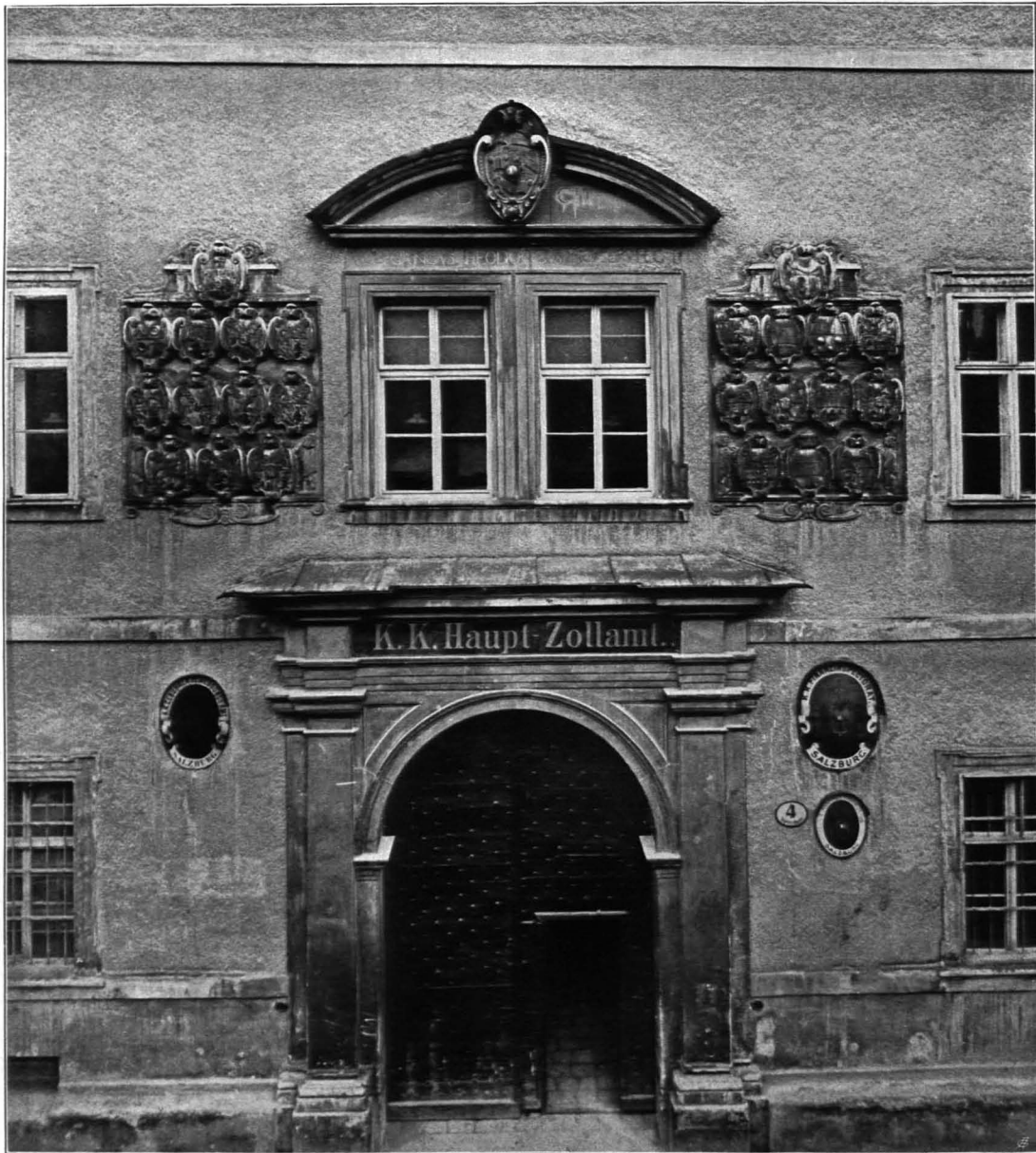
Fig. 84 K. k. Hauptzollamt, Portal (S. 69)
