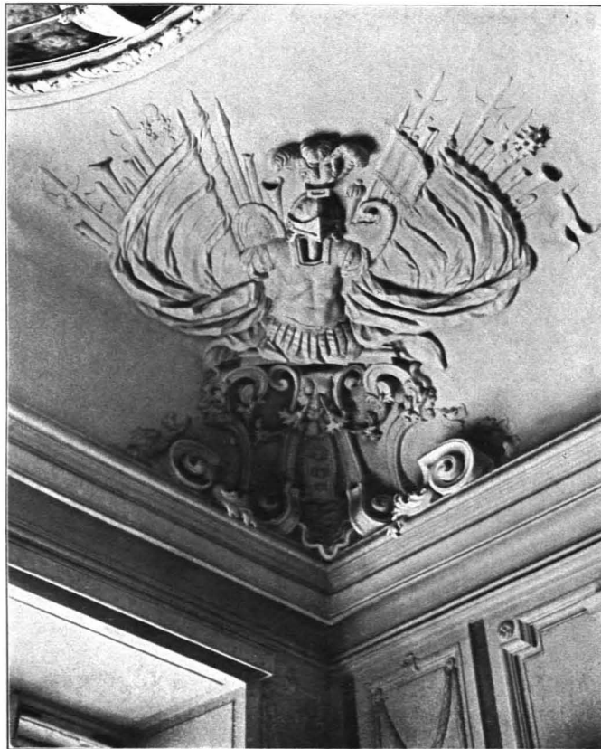
Fig. 17 Residenz, Stuckdetail aus dem Rittersaal (S. 19)
