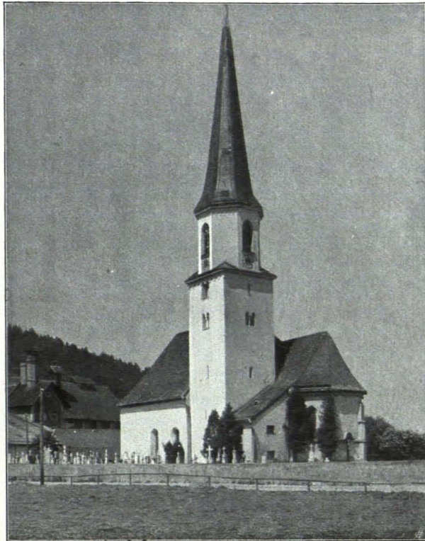
Fig. 109 Grödig, Pfarrkirche von Südosten (S. 112)
